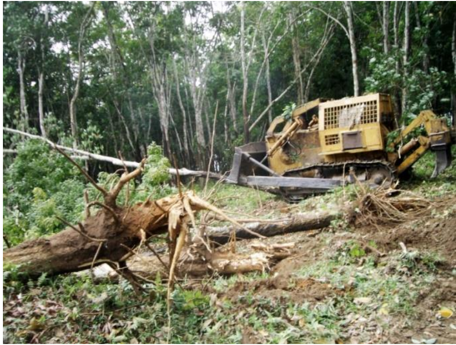
Figure 11 : Abattage des arbres au Bulldozer
