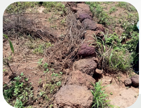
(ii) installation des cordons pierreux
