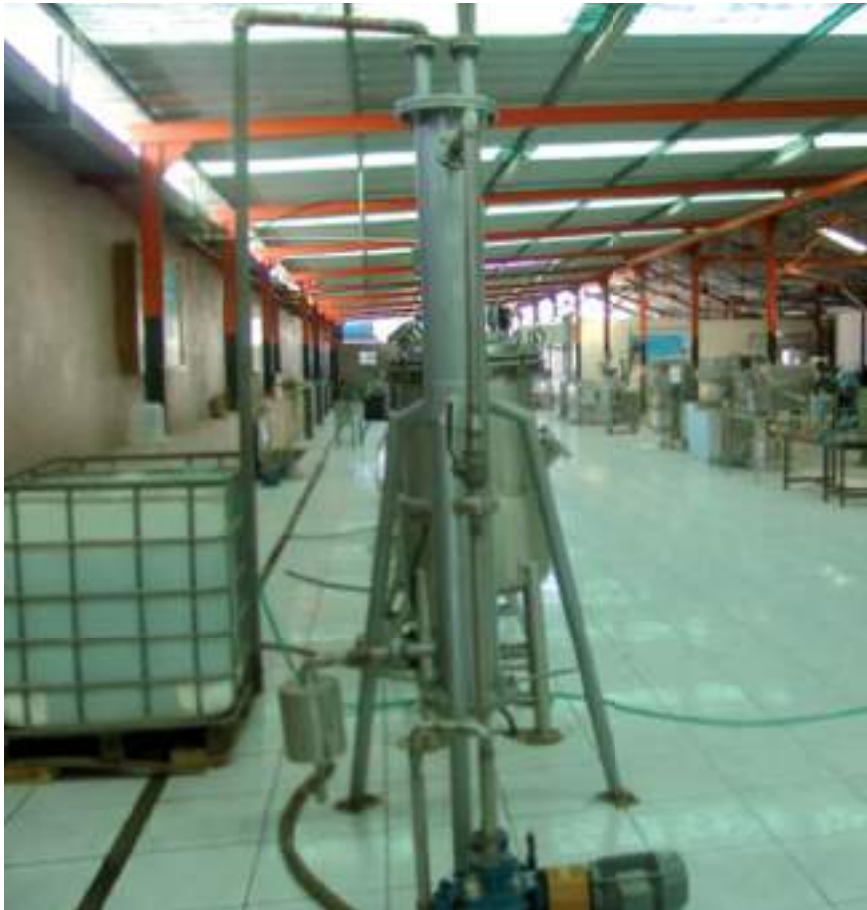
Hall équipé de matériel de traitements technologiques de produits agricoles
