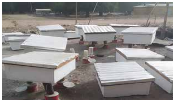
Confection de ruches en béton
