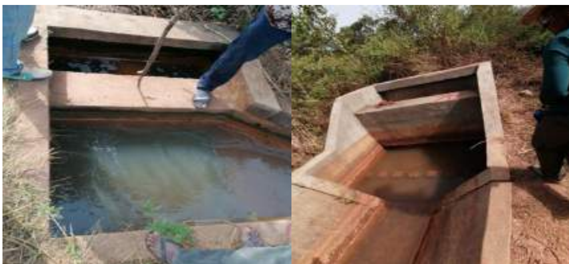
Planche 3-1 : Vues des bassins de dissipation rive droite (pleine charge) et rive gauche (sous charge) – Hambol 13
