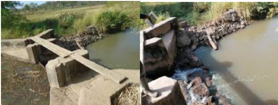
Planche 3-8: Vues de l'état de dégradation des perrés maçonnés – Planchage faisant office de passerelle – Tchologo 01
