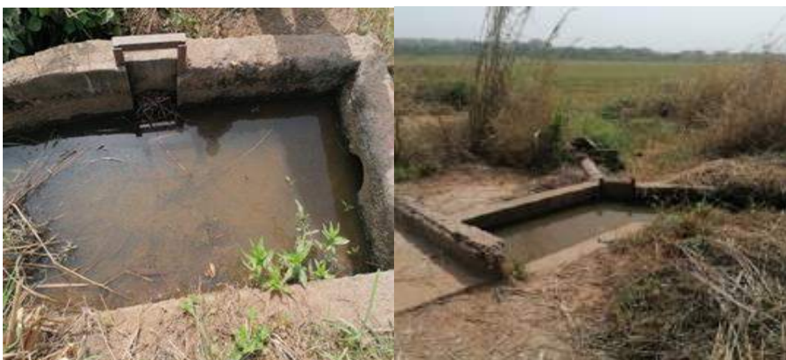
Planche 3-6 : Vues d'une prise parcellaire et d'une prise en tête de canal secondaire – Hambol 13
