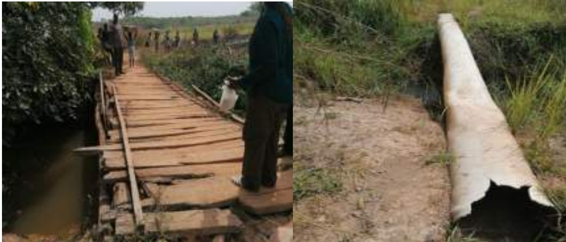
Planche 3-7 : Vues d'un ouvrage de franchissement piéton rudimentaire sur drain principal et du franchissement d'un canal secondaire sur drain principal – Hambol 13
