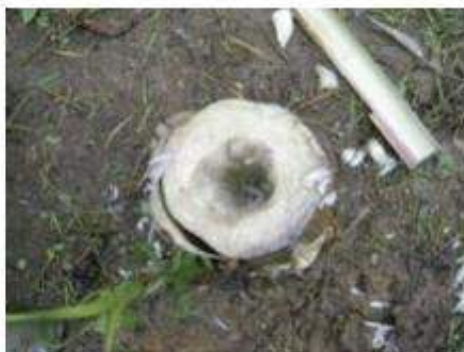
Vue de la cheminée
