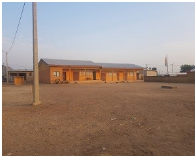
Photo 6 : Vue de l'école primaire de Sanankoro Source : BRLi-CI, Février, 2021
